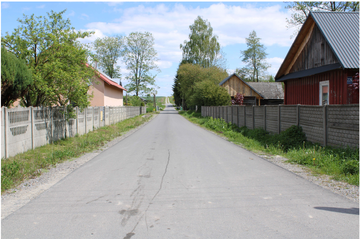
Przebudowa dróg na terenie Gminy Biszczka
