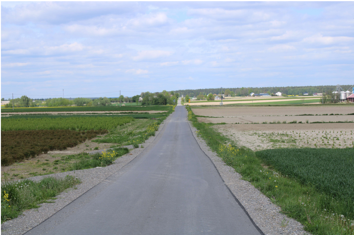
Przebudowa dróg na terenie Gminy Biszczka
