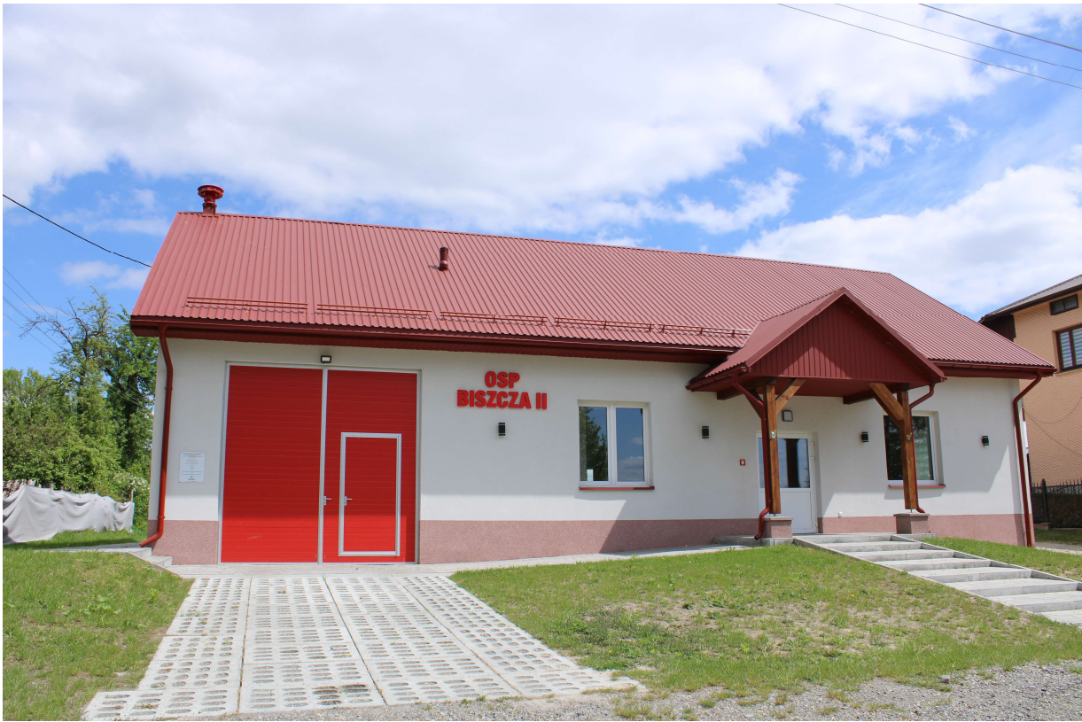
Modernizacja budynków użyteczności publicznej (Remiza OSP w Biszczy II)
