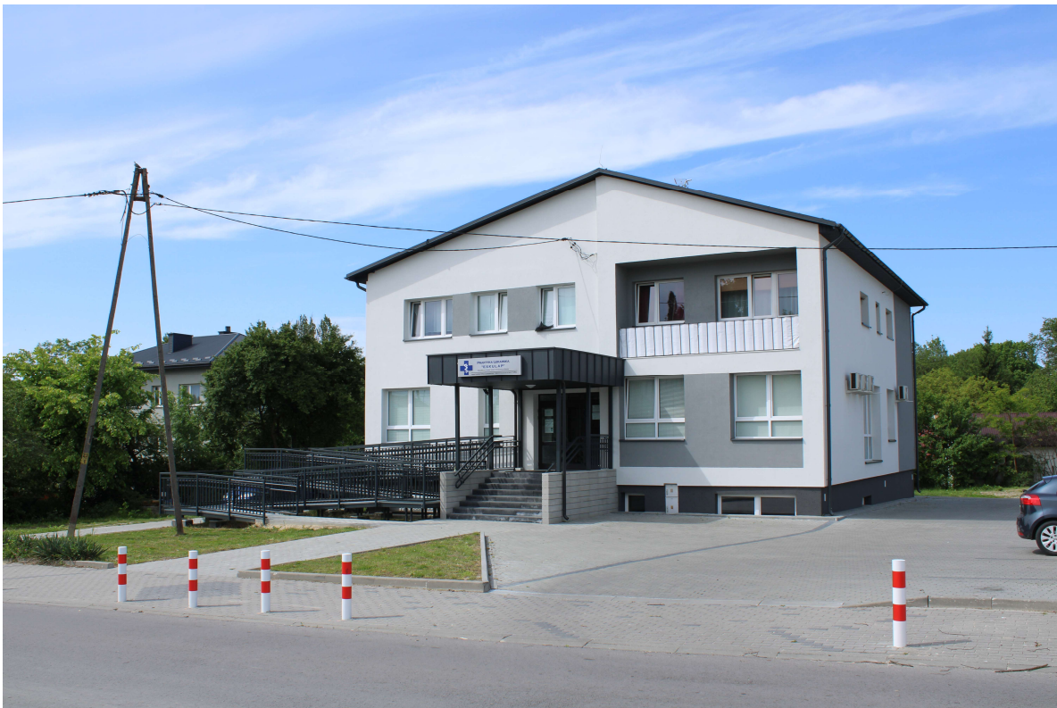
Modernizacja budynków użyteczności publicznej (Ośrodek Zdrowia)
