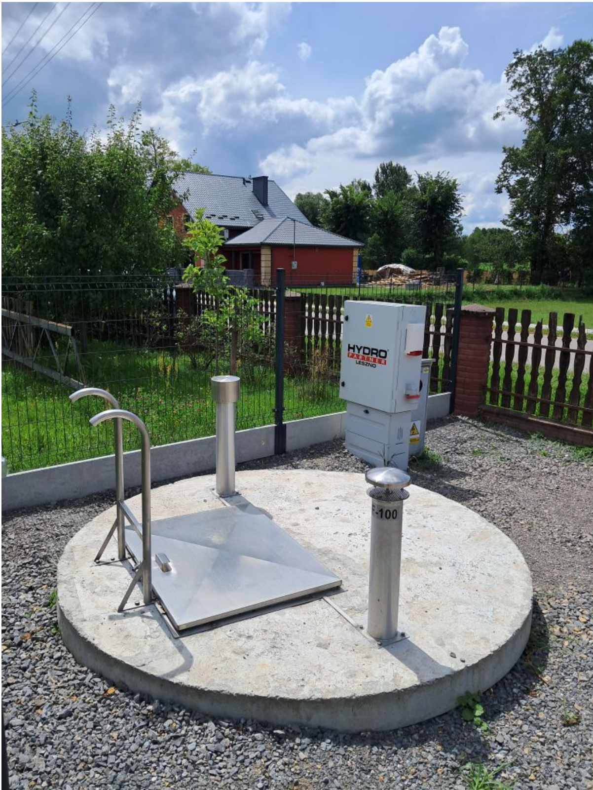
Modernizacja oczyszczalni ścieków w Biszczy (przepompownia)
