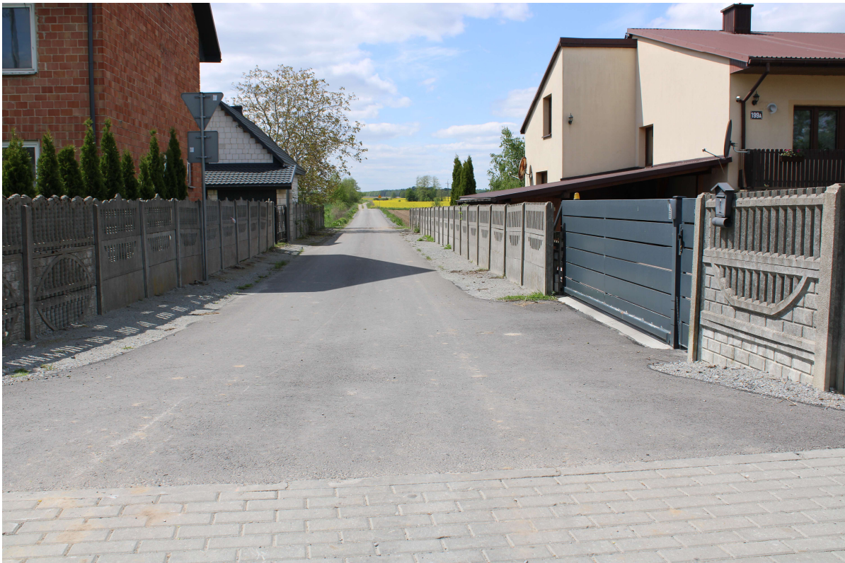
Przebudowa dróg na terenie Gminy Biszczka
