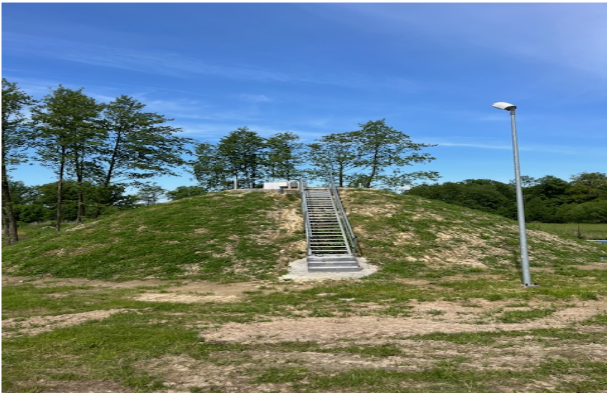
Modernizacja oczyszczalni ścieków w Biszczy (zbiornik wody Bukowina)
