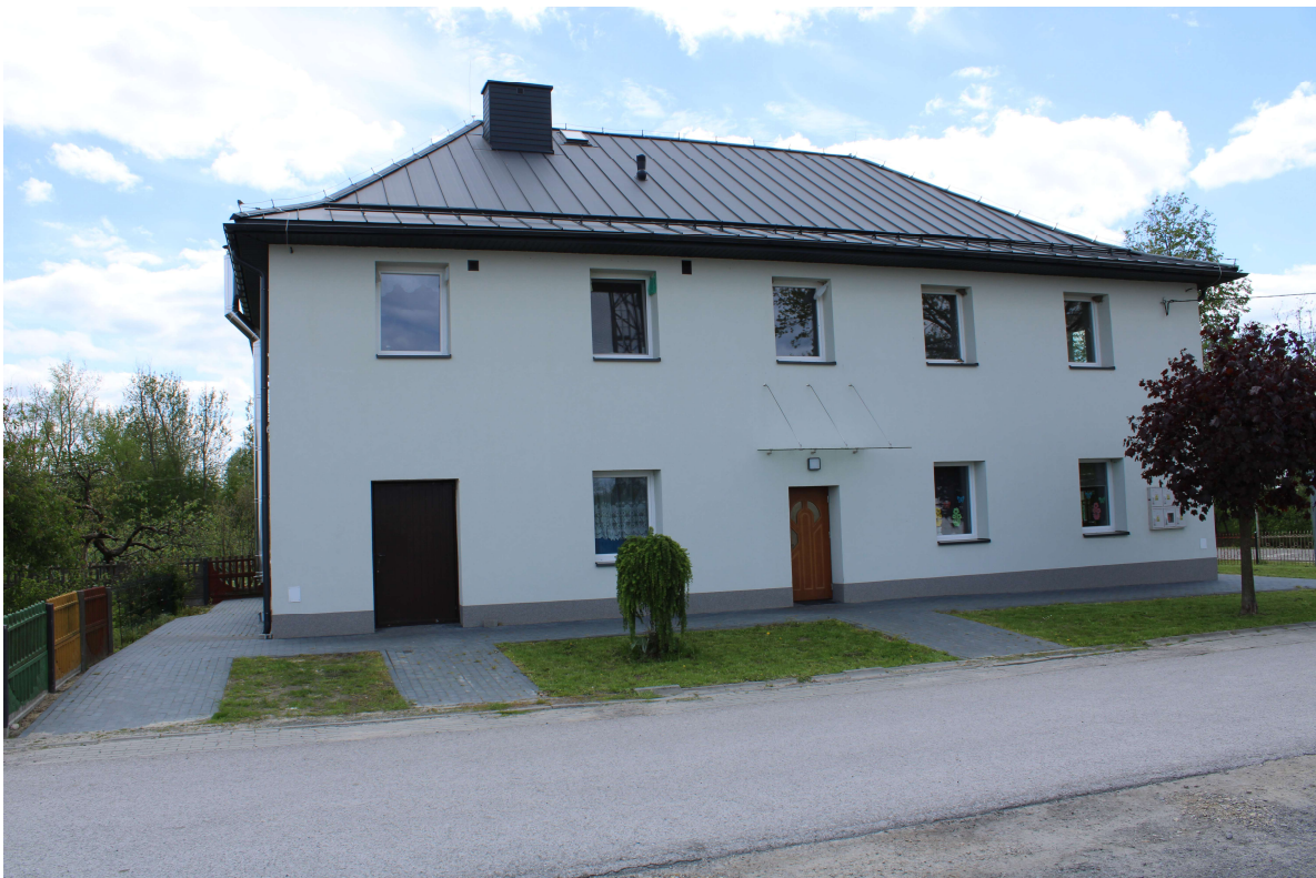
Modernizacja budynków użyteczności publicznej (Dom Nauczyciela w Bukowinie)
