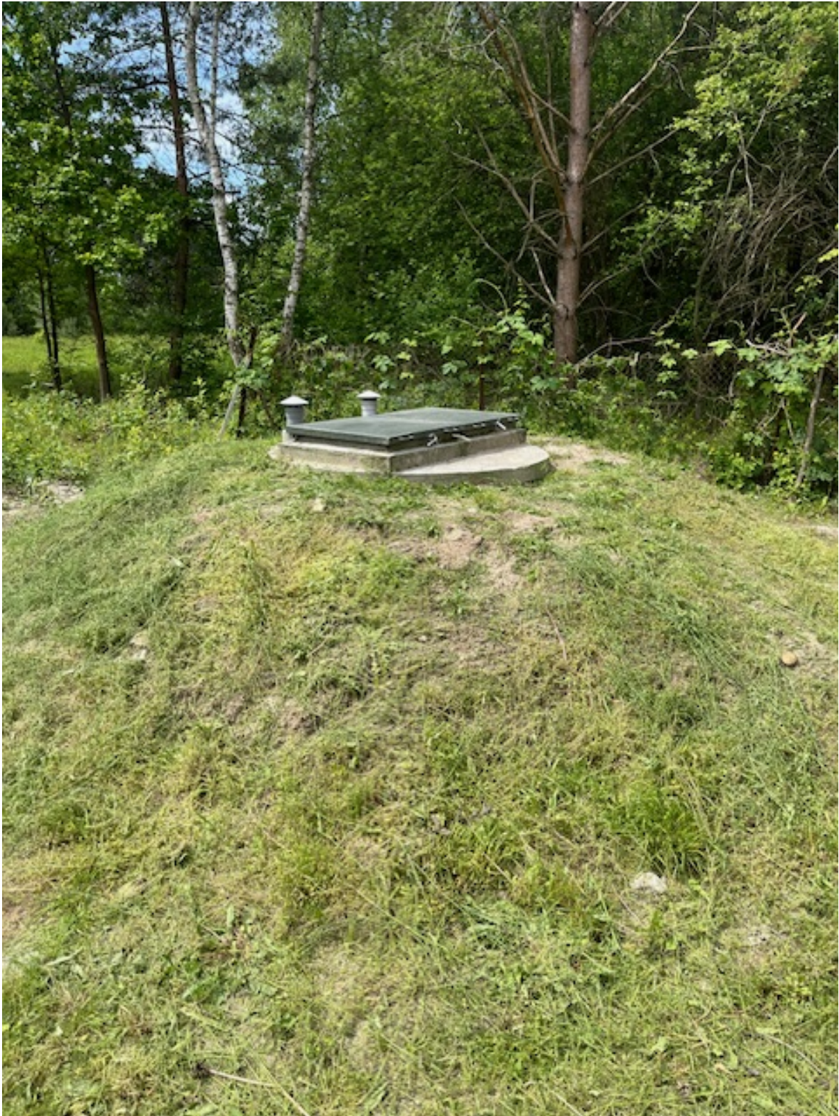
Budowa studni głebinowej S 10
