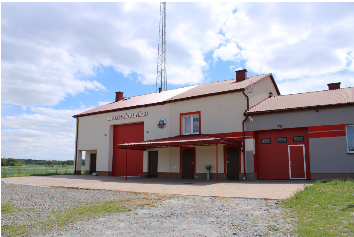
Modernizacja budynków użyteczności publicznej (Remiza OSP w Goździe Lipińskim)
