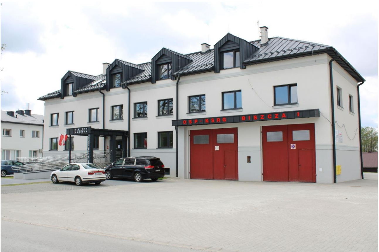
Modernizacja budynku GOKSiR w Biszczy
