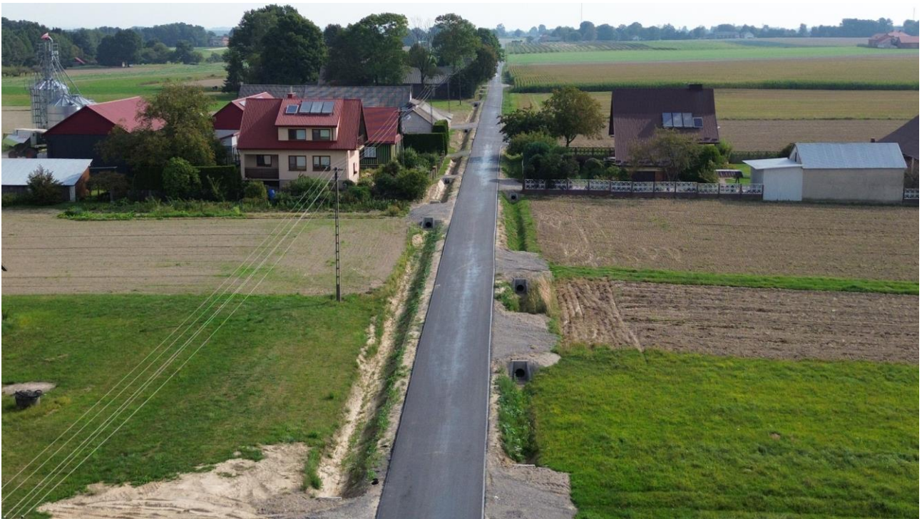
Przebudowa dróg na terenie Gminy Biszczka (Bukowina)
