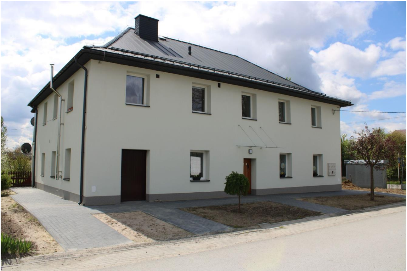
Modernizacja budynków użyteczności publicznej na terenie Gminy Biszczka (Dom nauczyciela w Bukowinie)
