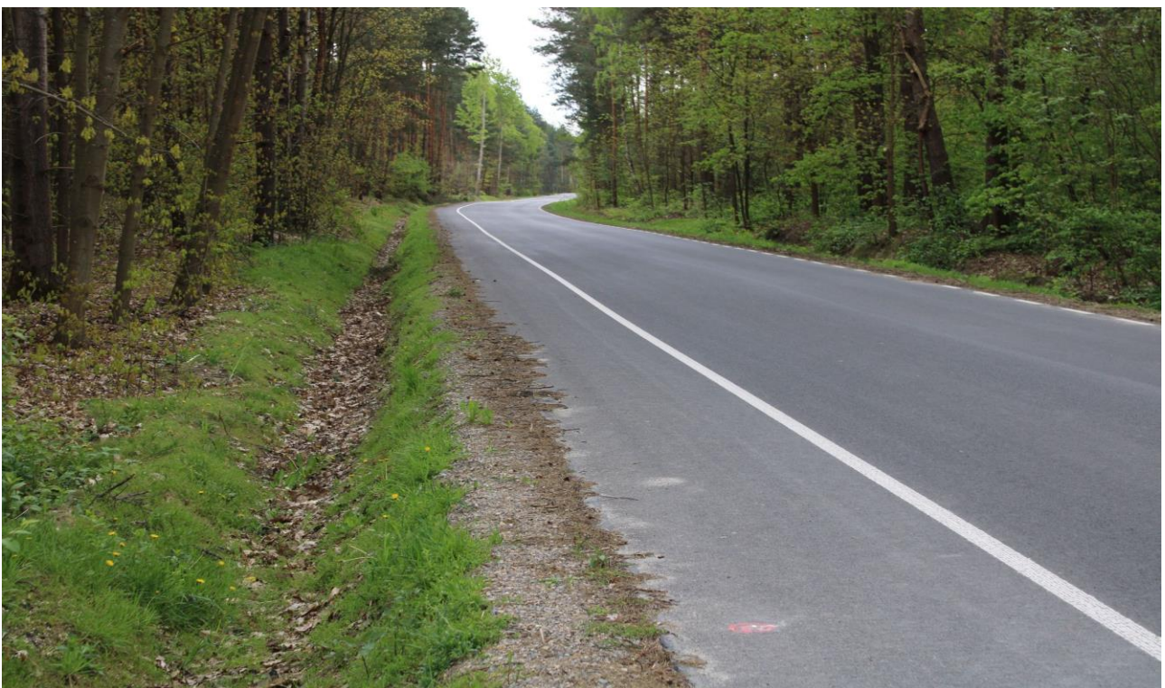
Budowa drogi powiatowej Żary – Książpol
