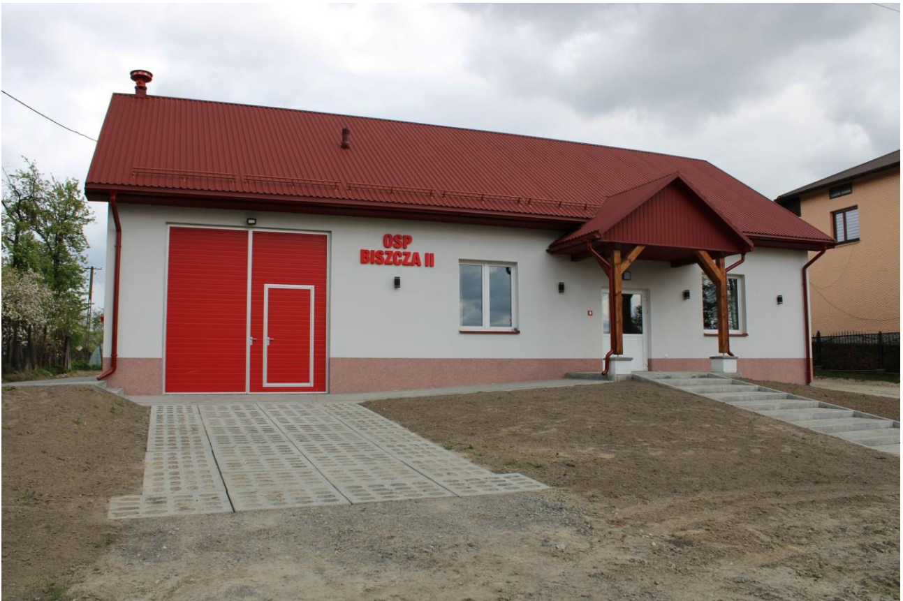
Modernizacja budynków użyteczności publicznej na terenie Gminy Biszcza (Remiza OSP w Biszczy II)
